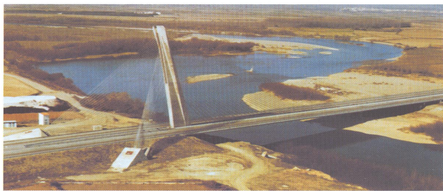
Fig. 8.18. Puente Sancho el Mayor (C.F. Casado, S.L.).
